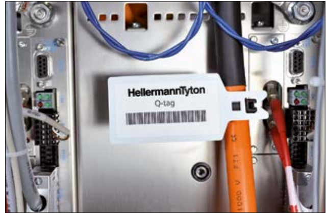
La orientación de la placa Q-tag asegura que el texto impreso esté fácilmente visible.
