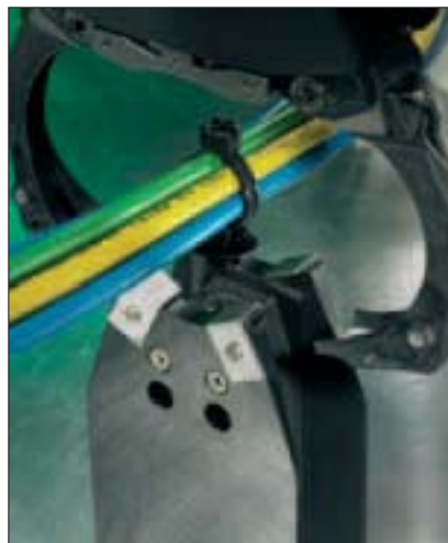
... quedando totalmente posicionada y atada al cableado.
