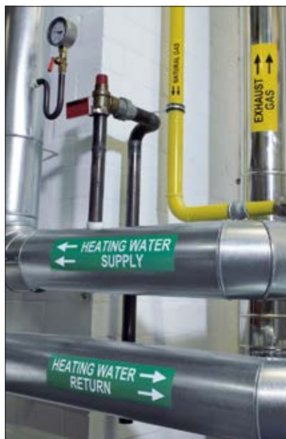
Marcaje de alta visibilidad para tuberías de gran longitud.
