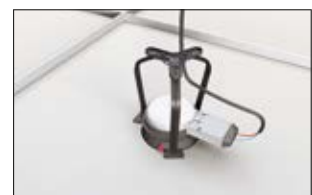
4. Conecte el downlight a la fuente de alimentación y fije el cable en el orificio de ruteado.
