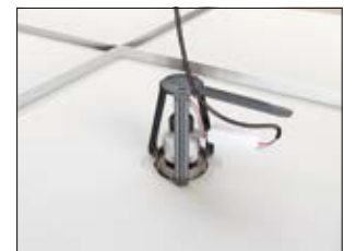
4. Conecte la fuente de alimentación y fije el cable en el retenedor.
