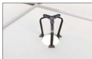
2. Presione los pines sobre la placa de yeso para evitar que se mueva.
