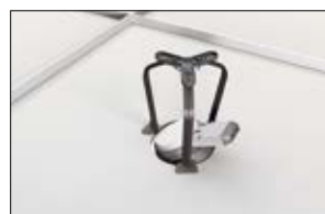
3. Instale el downlight acorde al manual del fabricante.
